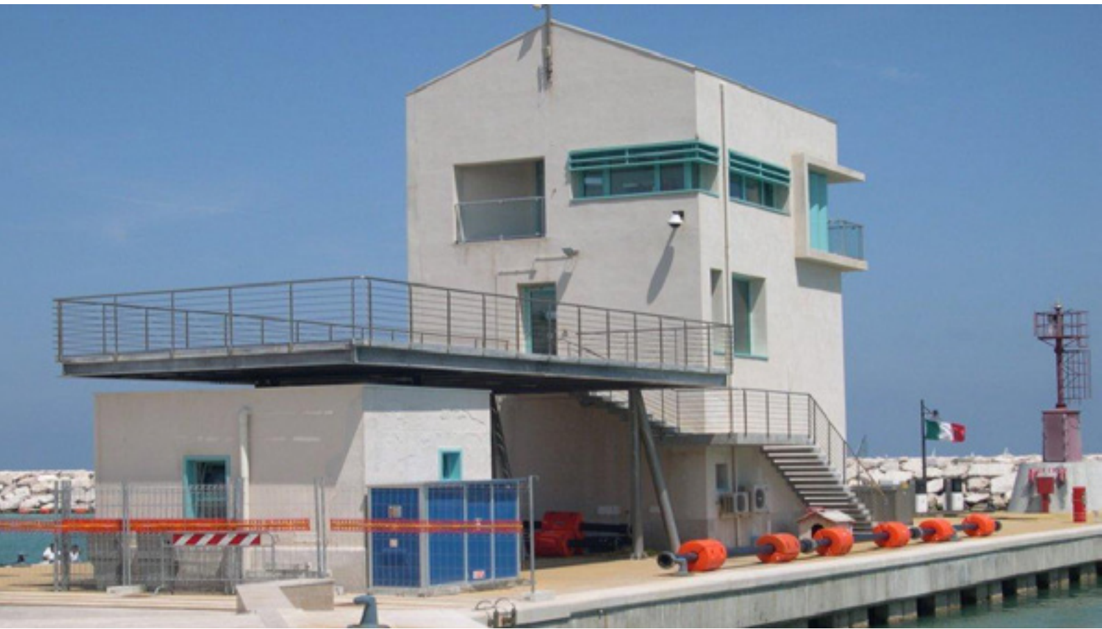
Torre di controllo
